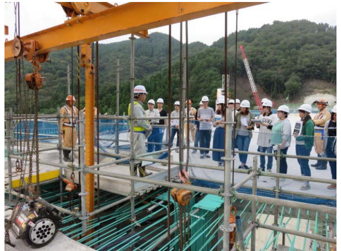
▲唐丹第2高架橋見学状況
